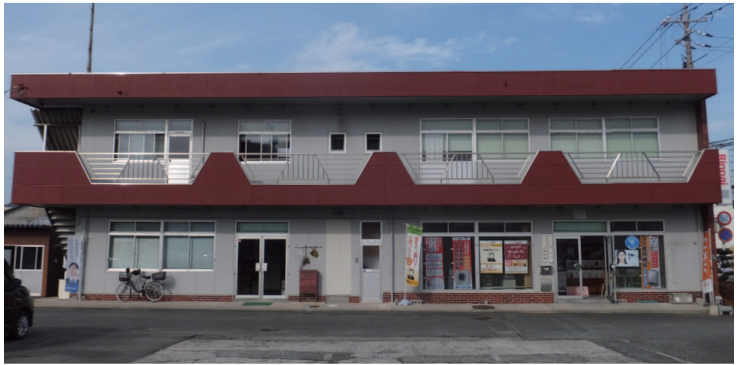
改装を実施する前の社屋外観
